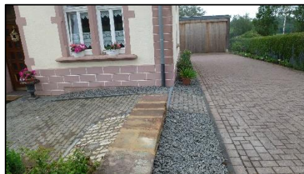
Abbildung 14: Beispiele von Objektschutzmaßnahmen (Überbogen, Geländemodellierungen, Aufkantung am Kellerfenster)
